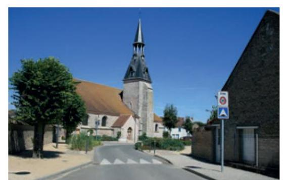
Entrée de zone 30 : réduction de la largeur de la chaussée et surélévation. Les végétaux bas renforcent le rétrécissement et change la perception de la voirie.
