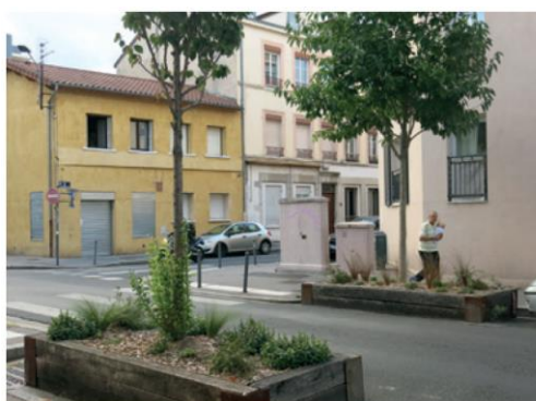
Neutralisation de places de stationnement, intégration de végétation, gain de visibilité au niveau du passage piéton
