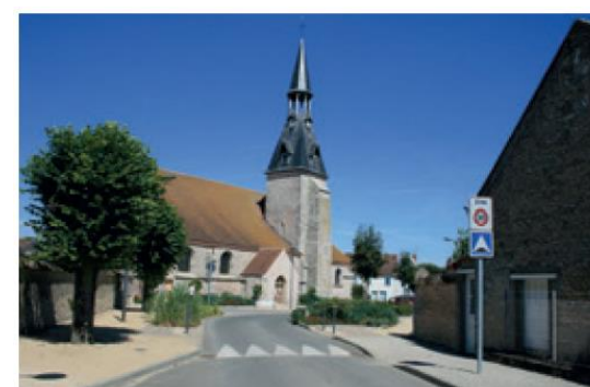
Entrée de zone 30 : réduction de la largeur de la chaussée et surélévation. Les végétaux bas renforcent le rétrécissement et change la perception de la voirie.
