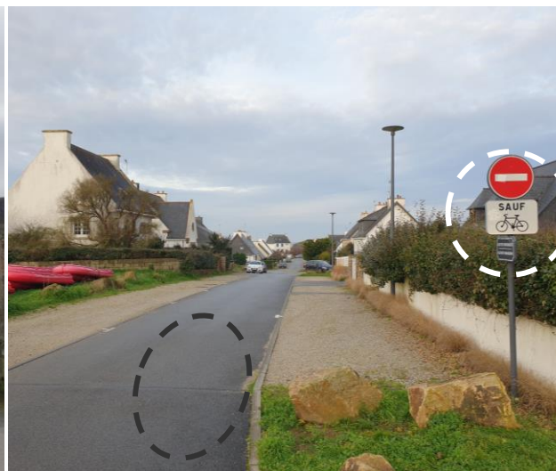
Double sens cyclable non matérialisé au sol pouvant inviter les cyclistes à circuler sur le trottoir
