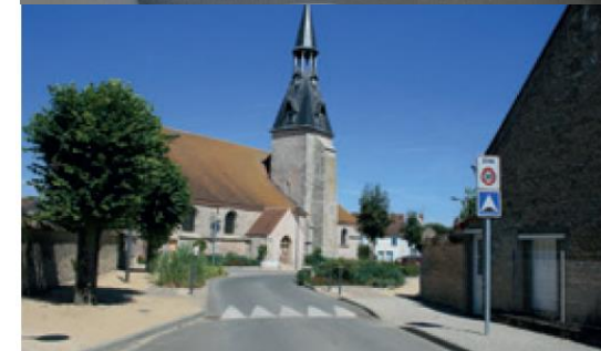
Réduction de la largeur de la chaussée et surélévation. Les végétaux bas renforcent le rétrécissement et changent la perception de l'espace
